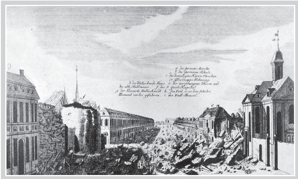
► Abb. 0.2: Spandauer Straße in Berlin nach der Explosion des Pulverturms im Jahr 1720
