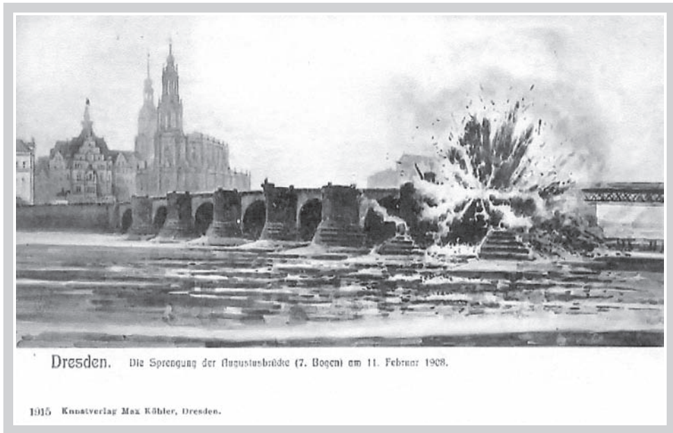
► Abb. 0.3: Dresden, die Sprengung der Augustusbrücke (7. Bogen)
