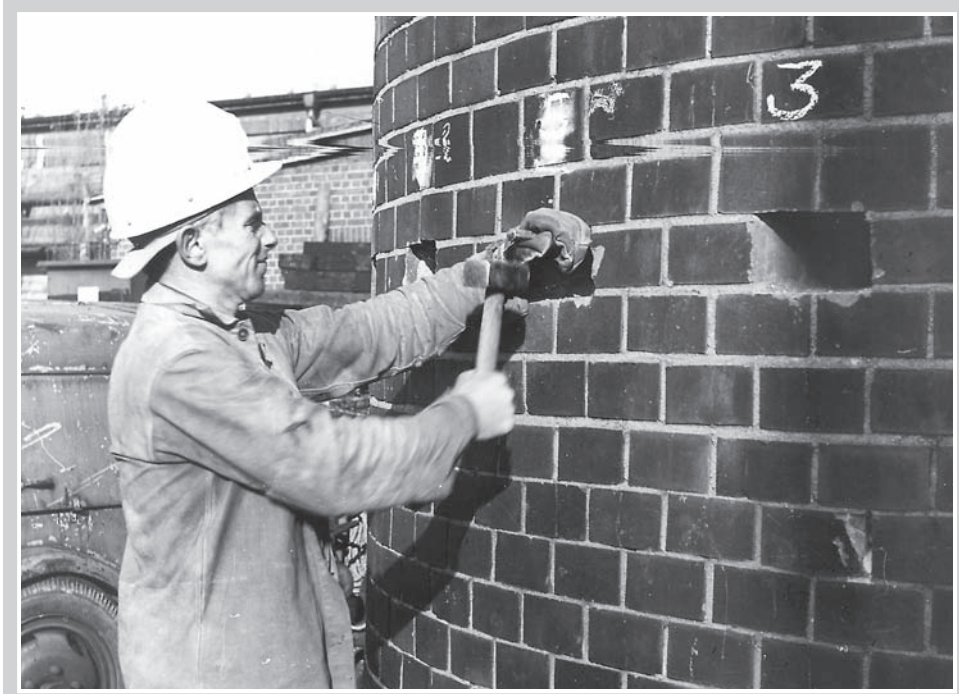
► Abb. 0.4: Herausstemmen von Ladekammern für die Sprengung eines Mauerwerkschornsteins
